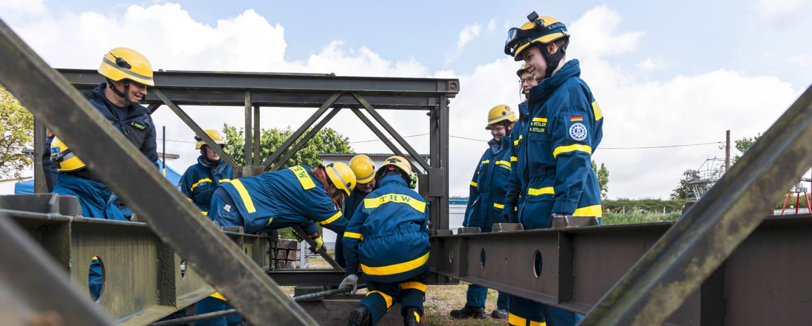
Beim Helferinnentag in Hoya stand unter anderem ein Brückenbau-Workshop auf dem Programm. | In one workshop female operatives built a road bridge.
