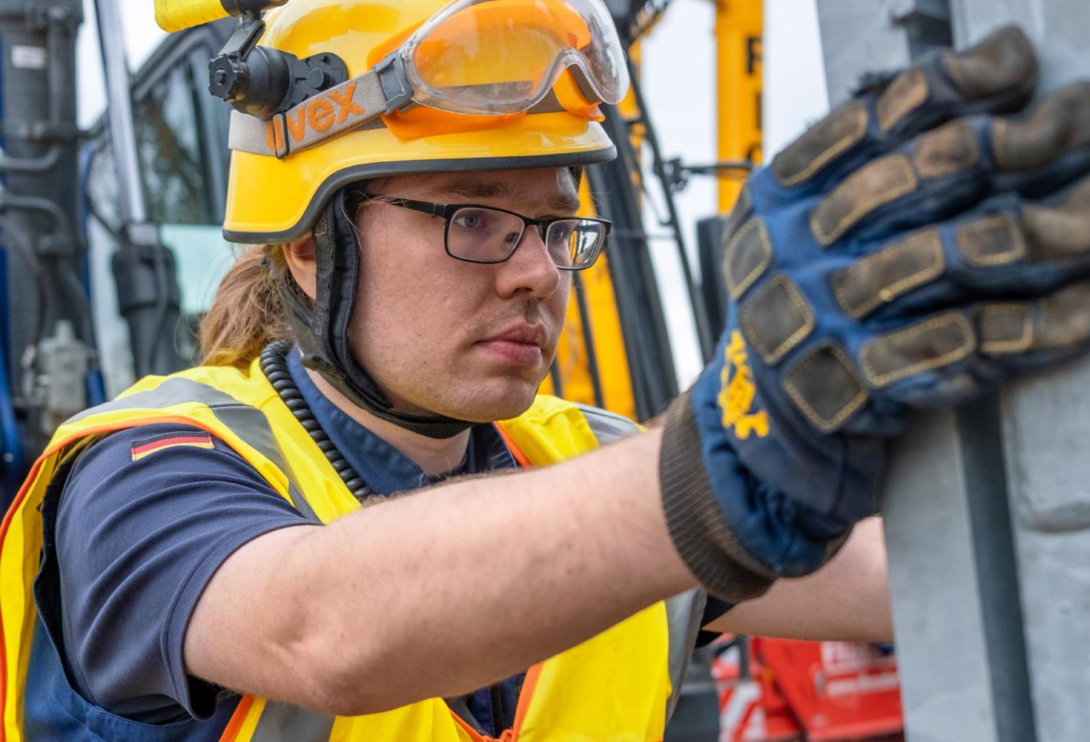
Nach wie vor im Einsatz war das THW 2022 auch beim Bau weiterer Behelfsbrücken an der Ahr. | In 2022 the THW continued its programme of temporary bridge construction along the River Ahr.
